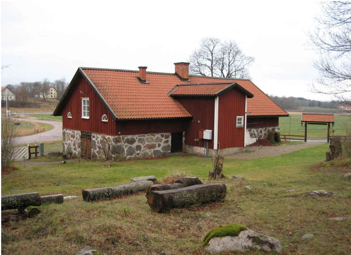
(Bild 8) Smedjan vid Harvestad. Trapphuset byggdes 1937 och ersatte en invändig trapp. Foto: Joakim Johansson 2006
