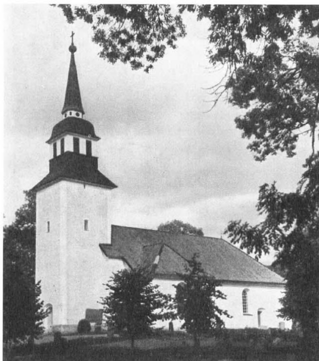
Landeryds kyrka. Ett ovanligt resligt 1700-talstorn höjer sig över en kyrkobyggnad, vars anor lätt spåras i de olika byggnadsskedena.
