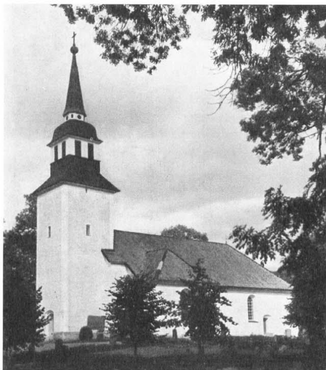
Landeryds kyrka. Ett ovanligt resligt 1700-talstorn höjer sig över en kyrkobyggnad, vars anor lätt spåras i de olika byggnadsskedena.
