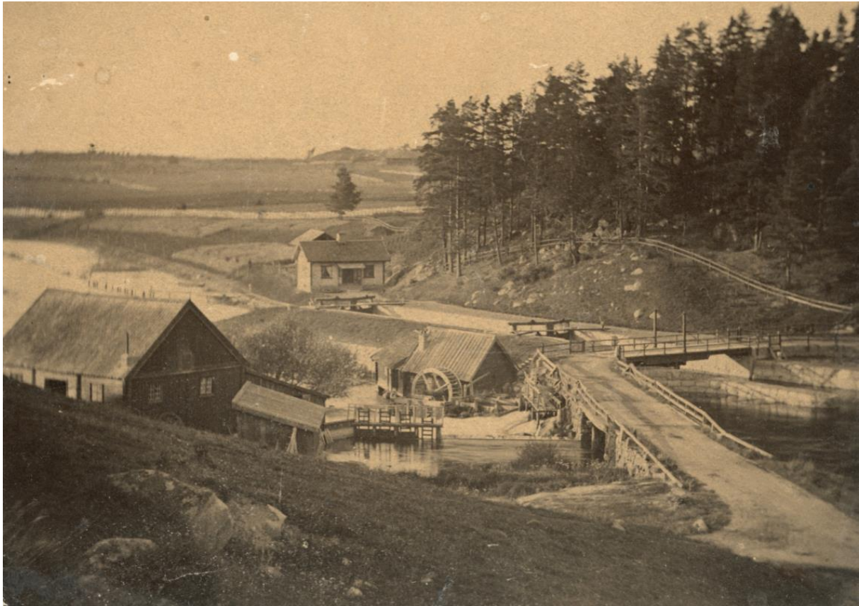
Hjulsbro med broarna över Stångåns fors och över slussen vid Kinda kanal. Slussvaktarbostaden ovan i mitten. Åkrar i norr i bakgrunden mot Skonberga. En skinnstamp mitt i forsén och Hjulsbro kvarn till vänster. På backen där fotografen stod, fanns tidigare två runstenar. Foto: Frans Dyring, cirka 1875. (Östergötlands Museum)
